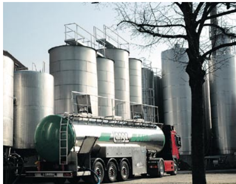
Aussenansicht der Heinrichsthaler Milchwerke. Vue extérieure de la fromagerie Heinrichsthaler.
